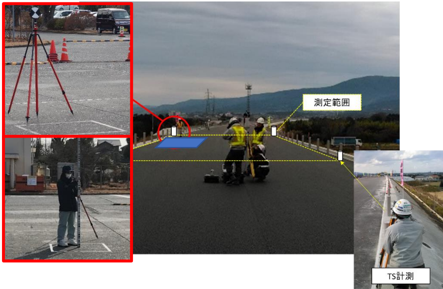
図3-31 地上移動体搭載型LSと検査面・検証点の計測（例）
